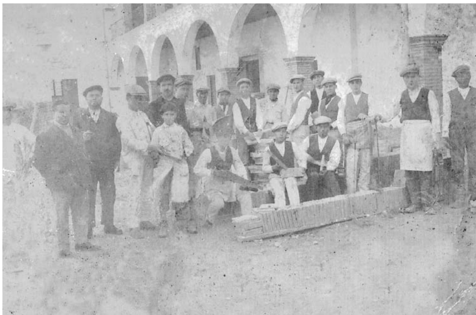
Obras de remodelación del Colegio de la calle San Agustín
